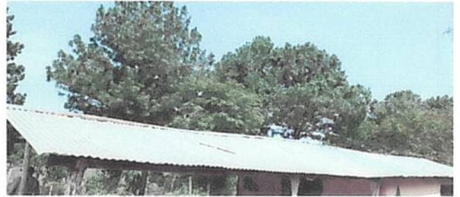
Desmontaje de lamina y estructura
