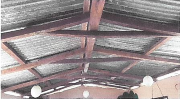
Sustitución de lamina normal por lamina troquelada alusin calibre # 26.
